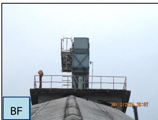
ภาพที่ 2.8 ระบบดักฝุ่นแบบ Bag Filter (BF)
