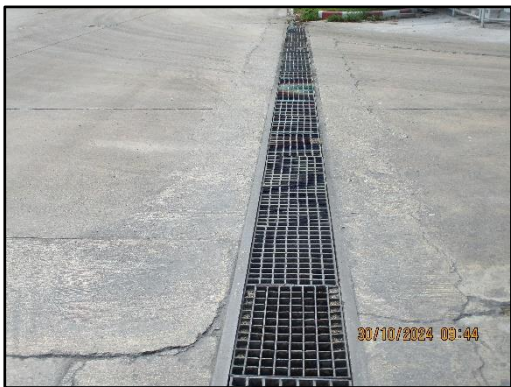
ภาพที่ 2.35 รางระบายน้ำในพื้นที่โครงการ
