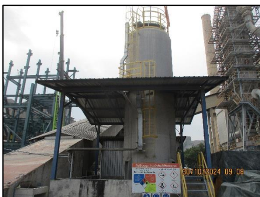
ภาพที่ 2.7 การติดตั้งระบบฉีดแอมโมเนียอัตโนมัติ (Ammonia spray system) และการติดตั้งระบบป้องกันและควบคุมความดันของถังแอมโมเนีย
